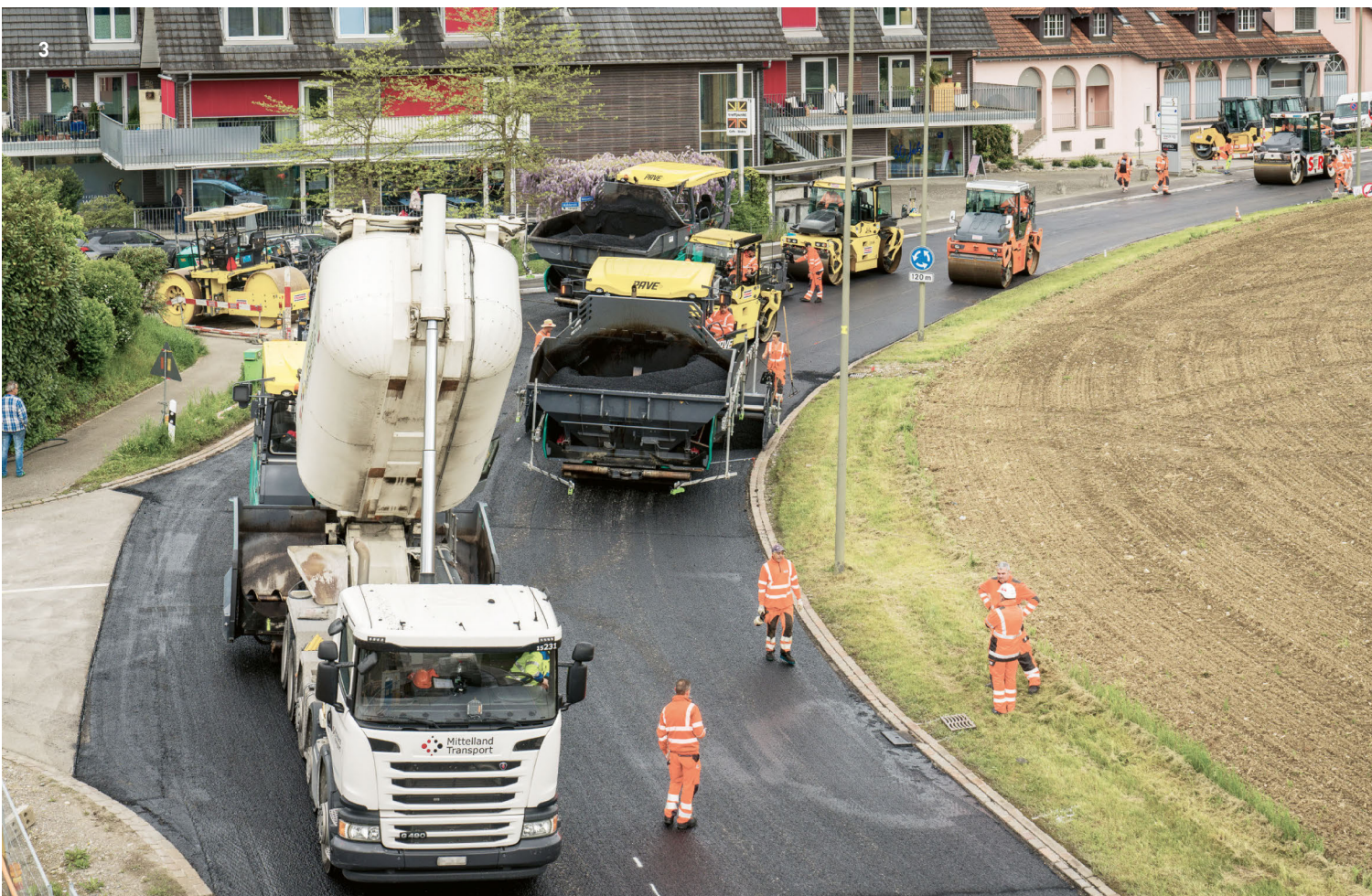
1 Belageinbau, Mosseedorf 2 Sanierung Aarwangenstrasse, Wynau 3 Asphaltierung Weinlandstrasse, Andelfingen
