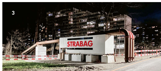
1 Strassenüberquerung für Grundwasserabsenkung, PU ZAS, Zürich-Altstetten / 2 Wellpointarbeiten, MFH Seestrasse, Küsnacht ZH / 3 Wasserbehandlungsanlage für Grundwasserabsenkung, Polizeigebäude, Aarau AG
