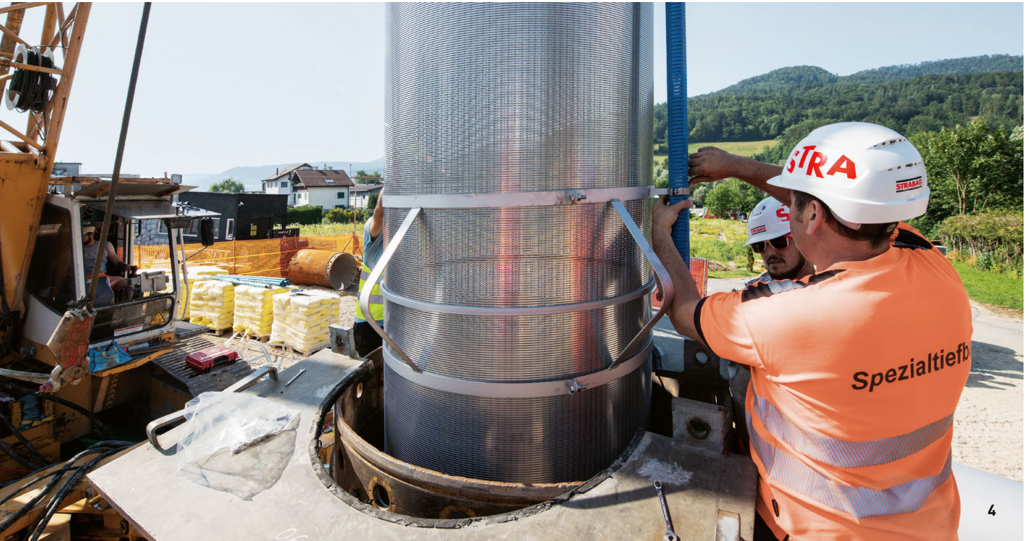
4 Einbau eines Edelstahlbrunnens, GWPW Leim, Thürnen BL / 5 Erstellung eines Trinkwasserbrunnens mittels Greiferbohrung, GWPW Chlosterlinde, Diessenhofen TG / 6 Langzeitiger Pumpversuch à 10 000 l/min, GWPW Aarefeld, Gretzenbach SO
