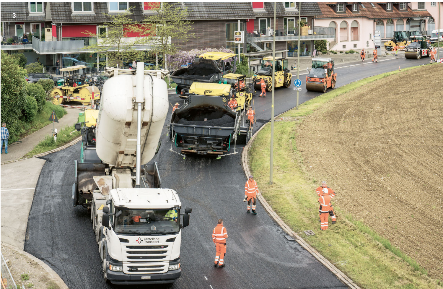
1 Belagserneuerung Flugplatz, Dübendorf 2 Sanierung Aarwangenstrasse, Wynau 3 Asphaltierung Weinlandstrasse, Andelfingen
