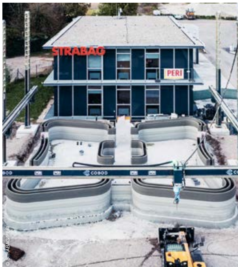
Das erste 3D-gedruckte Gebäude Österreichs in Hausleiten
