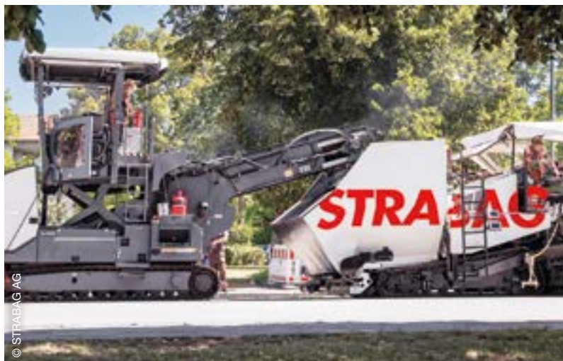
CIAir® Asphalt-Einbau mit dem Innovationsfertiger der STRABAG AG in Erlangen
